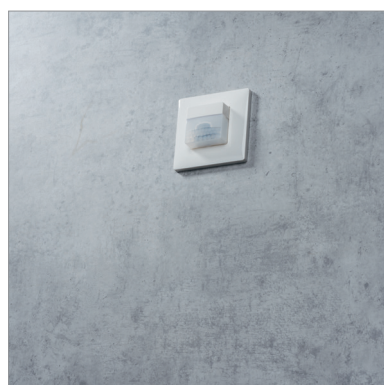
Montage jusqu'à 2,2 m de hauteur
