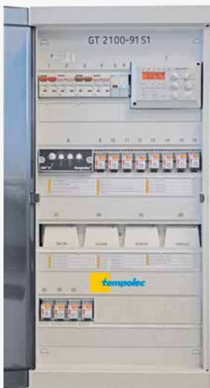
Schakelkast met 2 weersafhankelijke regelaars: SAM2100 en SAM91
